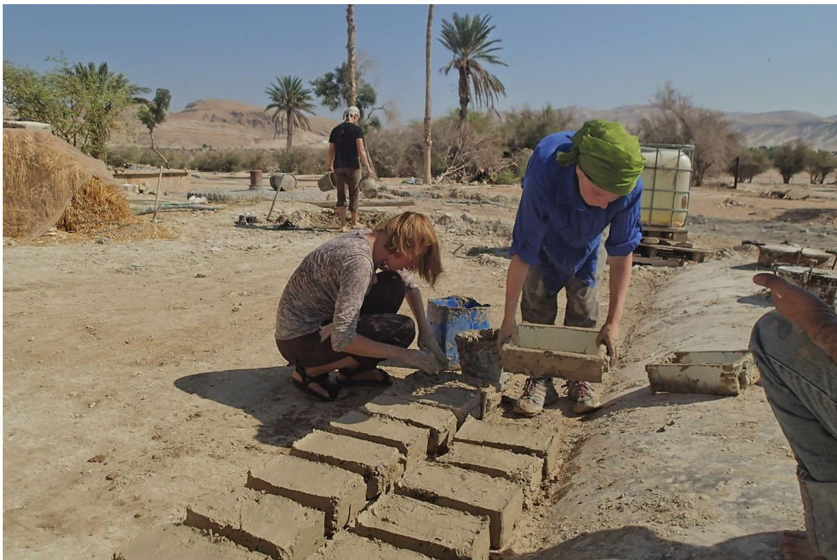
Vytváříme cihly z hlíny a slámy, které jsou vypálené během tří dnů a může se z nich začít stavět škola.
