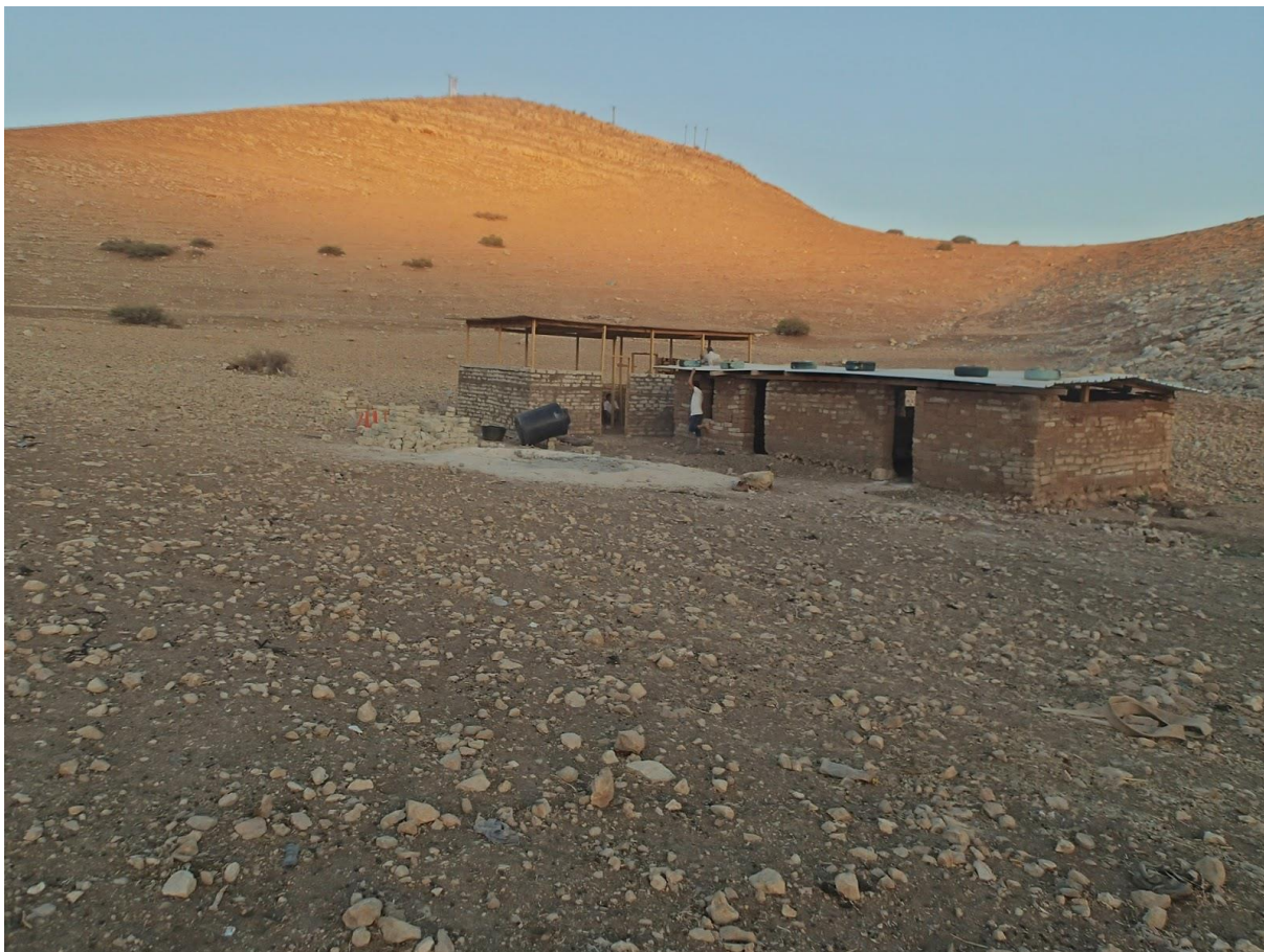
Začátek stavby již čtvrté školy. Tato škola je v Samře na severu Jordánského údolí. A budou do ní chodit děti ze čtyř komunit, kde bydlí asi 60 rodin.
