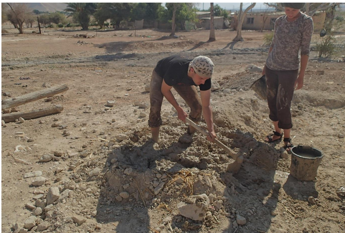
Obrázek 1: Příprava materiálu k výrobě nepálených cihel. Použita byla hlína, sláma a voda. Na fotografii zleva Vojtěch Mrázek a Silvia Hílková.
