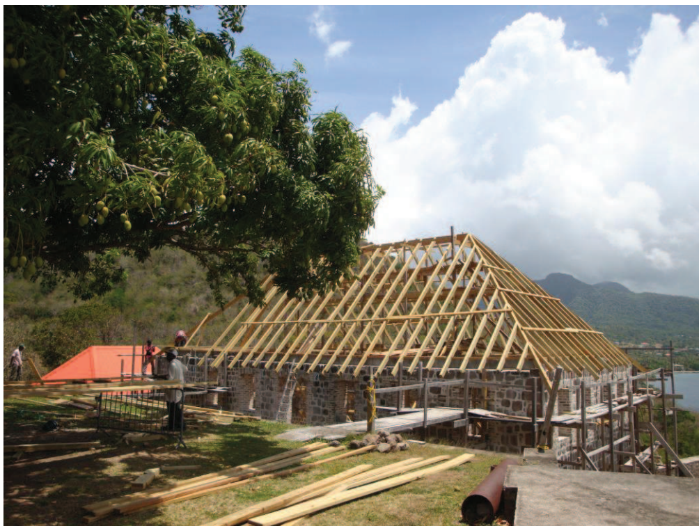
Obrázek 6: Cabrits NP, místní dělníci opravují Fort Shirley
